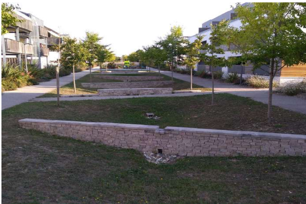
Lotissement avec gestion des eaux pluviales intégrée aux espaces verts à Périgny
