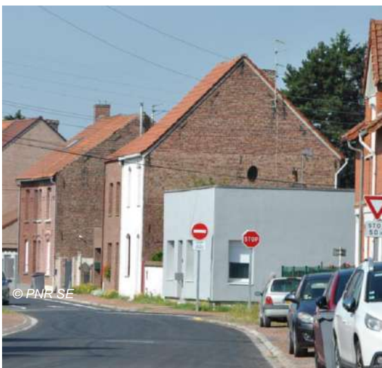
confrontation de bâtis d'époques différentes : une maison contemporaine de couleur grise avec une toiture plate aux côtés d'une maison traditionnelle (briques, toiture à 2 pans en tuiles rouge-orangé)
