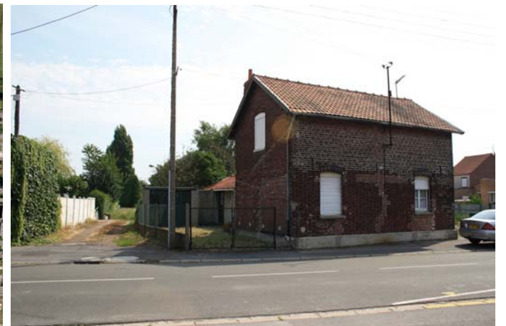
Maison de garde barrière rue Emile Zola
