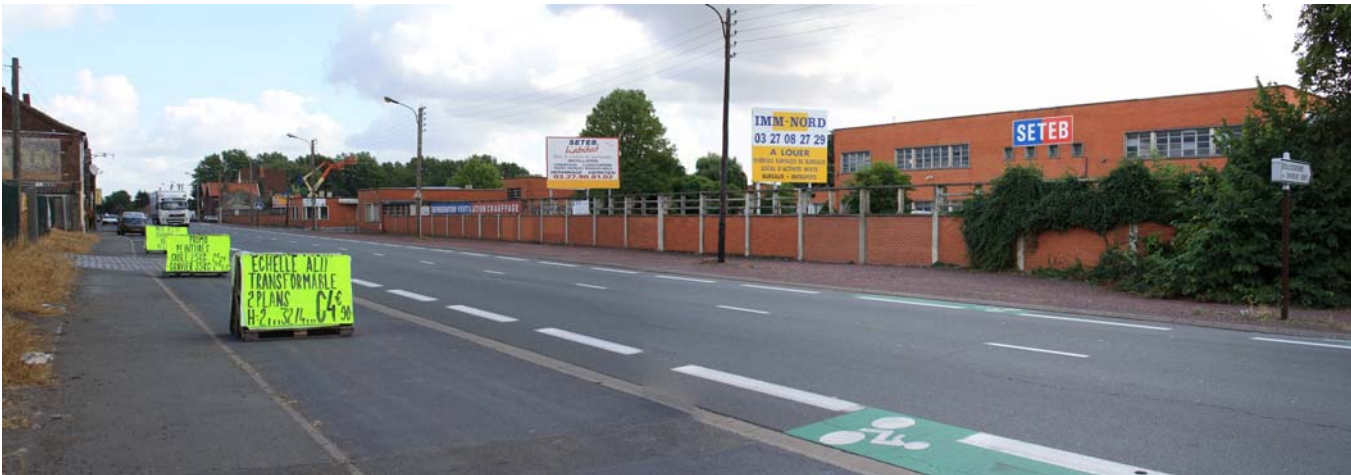
Anciennes usines « les textiles de Douai » sur la route de Tournai-Douai
