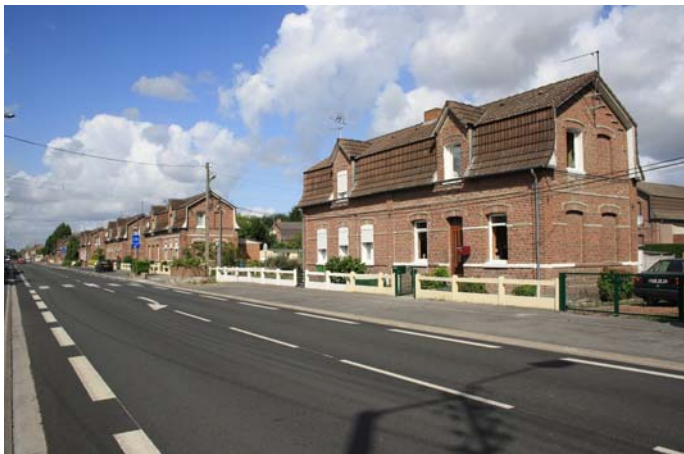
Cité pavillonnaire Bois Bommart, Flers en Escrebieux
