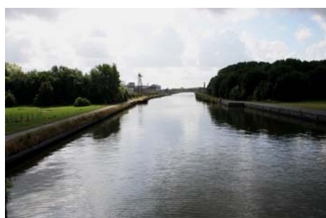
Canal de dérivation de la Scarpe
