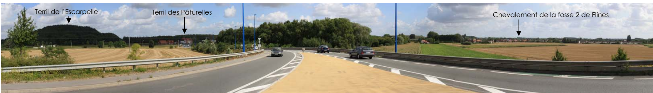
Echangeur de Waziers, intersection de la route Tournai-Douai et l'A21.
