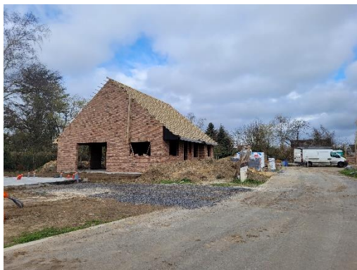
Figure 5 - Construction d'un nouveau logement en cours
